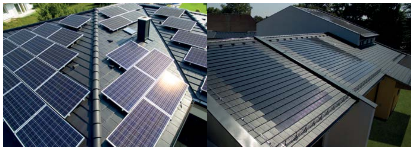
Sistem fotovoltaic clasic cu panouri mari
